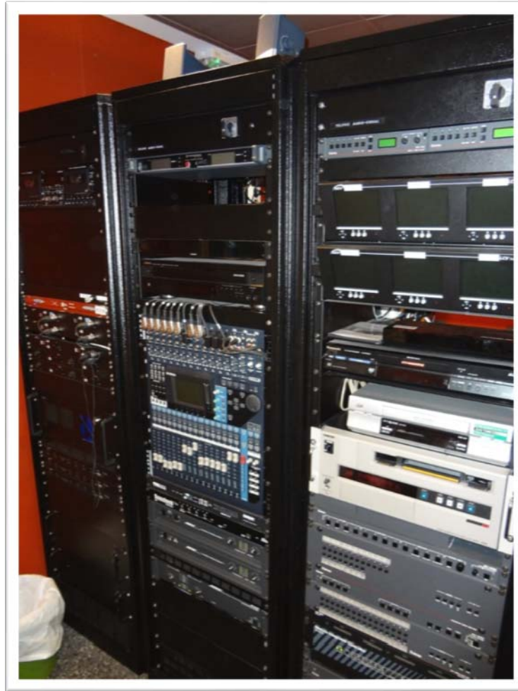
Abbildung 9: Steuerzentrale - 19"-Racks
